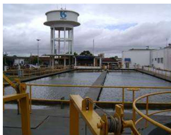
Figura 3 - Estação de Tratamento de Água (ETA).
