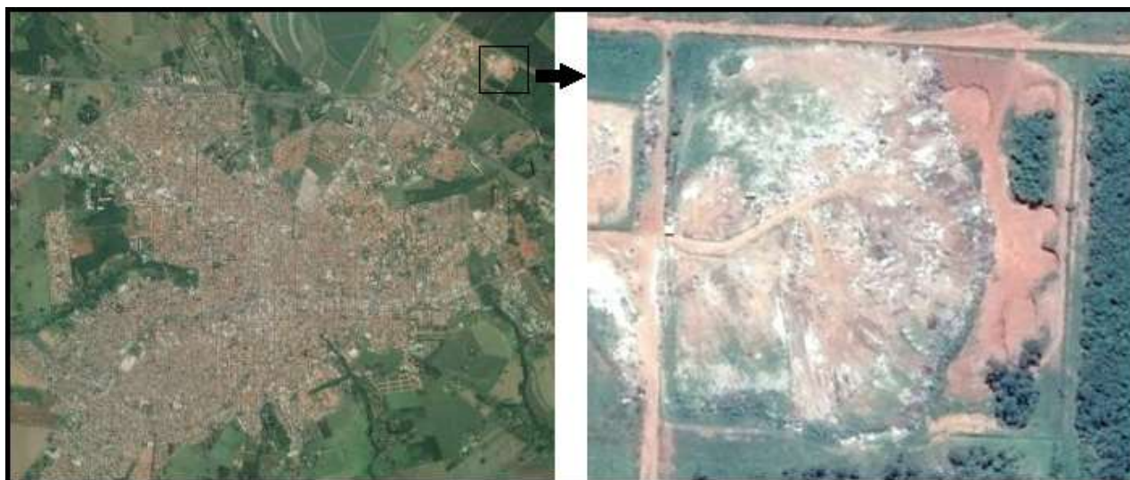
Figura 10 - Aterro de Resíduos Inertes.
